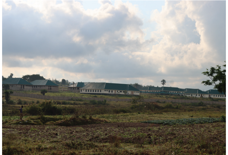
HOSPITALI YA WILAYA : Muonekano wa hospitali ya Wilaya hadi sasa Jumla ya Tsh Bilioni 3.1 zimepokelewa kwa awamu tatu tofauti kutoka Serikali kuu na jumla ya majengo 14 yameshajengwa majengo 11 yamekamilika na baadhi ya huduma zinaendelea
