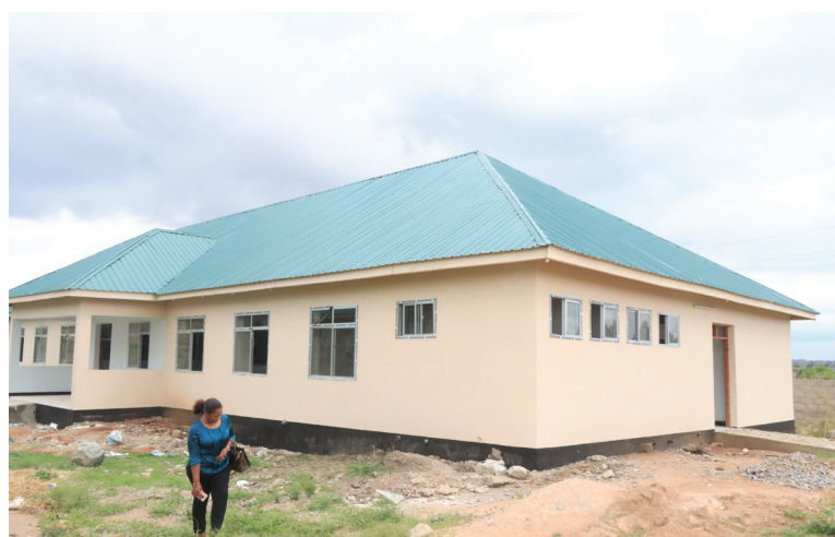
JENGO LA KUHIFADHIA MAITI: Ujenzi wa jengo la kuhifadhia maiti katika hospitali ya Wilaya hadi sasa Jumla ya Tsh Bilioni 3.1 zimepokelewa kwa awamu tatu tofauti kutoka Serikali kuu na jumla ya majengo 14 yameshajengwa
