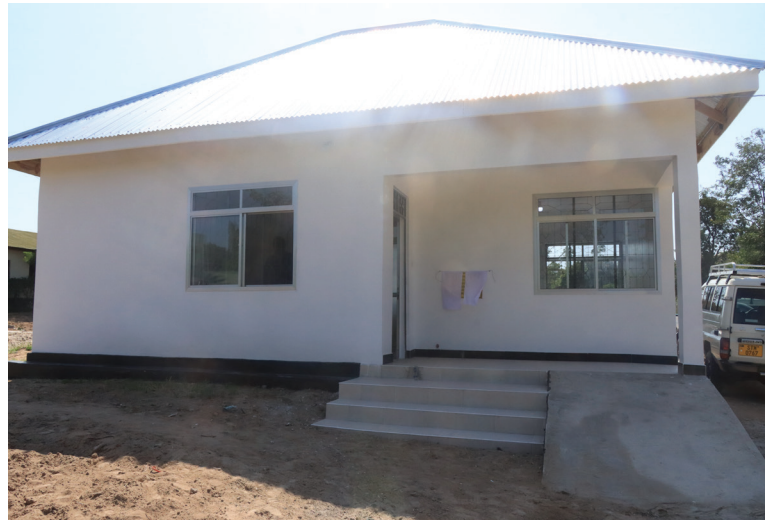
Tsh Milioni 40 za mapato ya ndani ya Halmashauri zimetumika kukamilisha ujenzi wa jengo la kujifungulia katika Zahanati ya Illemela ujenzi ulianzishwa kwa nguvu za wananchi na fedha za mfuko wa Jimbo
