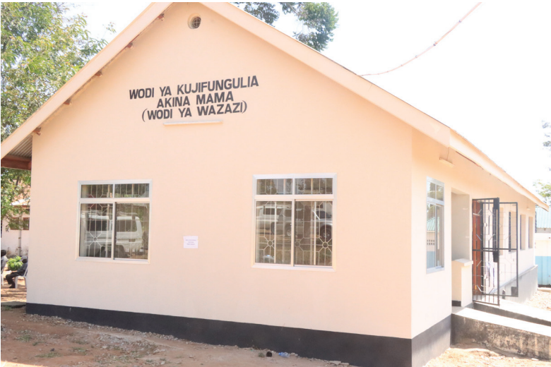
Tsh Milioni 40 za mapato ya ndani ya Halmashauri zimetumika kukamilisha ujenzi wa jengo la kujifungulia katika Zahanati ya Nyakato ujenzi ulianzishwa kwa nguvu za wananchi na fedha za mfuko wa Jimbo
